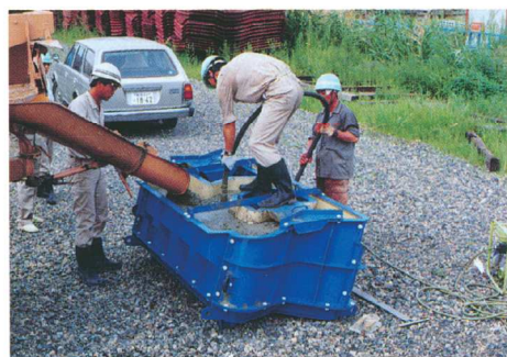
(4)コンクリート打設
