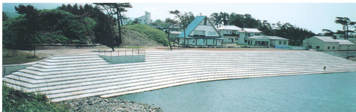
施工場所 秋田県象潟町 施工年月日 平成9年 事業名 象潟漁港海岸保全整備(高潮)事業 事業主体 由利農林事務所 ブロック名 ビーチロックⅢ型3t ビーチロックⅢ型(モ)3t
