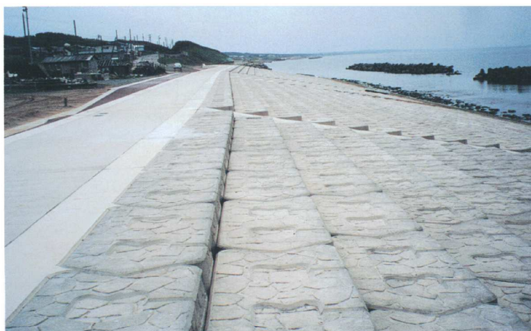
施工場所 青森県市浦村市浦海岸 施工年月日 平成4年～ 事業名 市浦海岸侵食対策工事 事業主体 五所川原土木事務所 ブロック名 ビーチロックⅢ型(モ)2t
