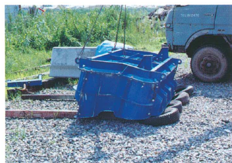
(7)型枠解体前ブロック反転
