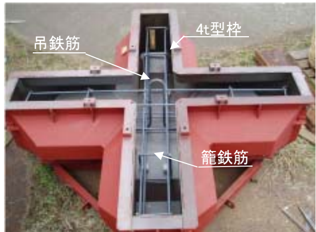
型枠組立状況
